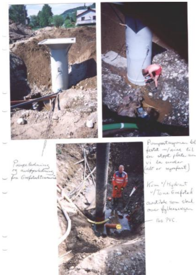
Figur 6: Utgraving og etablering av eksisterende pumpestasjon (trolig eksisterende pumpestasjon der ny pumpestasjon lengst øst skal etableres).
